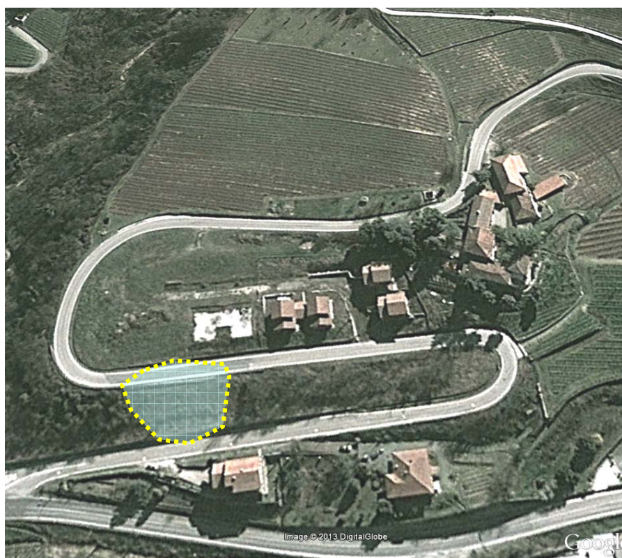
Fig. 18 - Vista aerea dell'area con indicazione del dissesto 2009.
