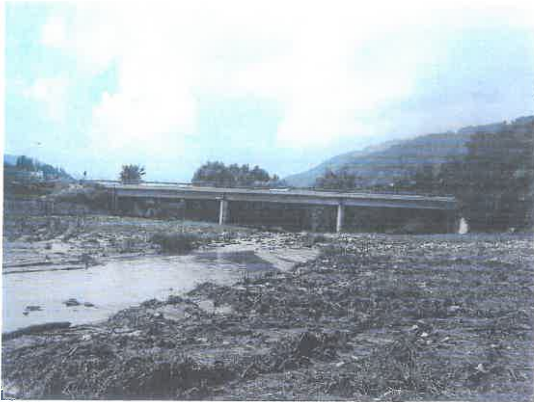
Fig.1 – Torrente Belbo, ponte 19.25.
